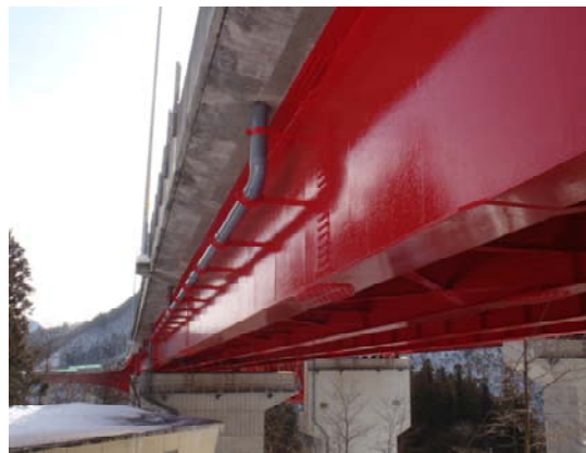
鋼桁の塗替塗装
