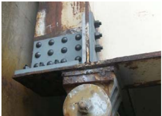
鋼桁の当て板補修
