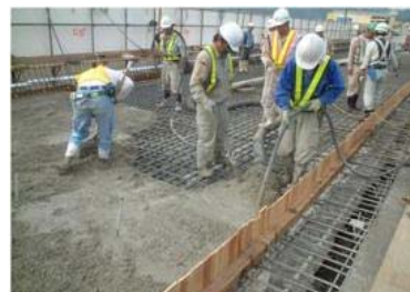
床版上面の部分打替
